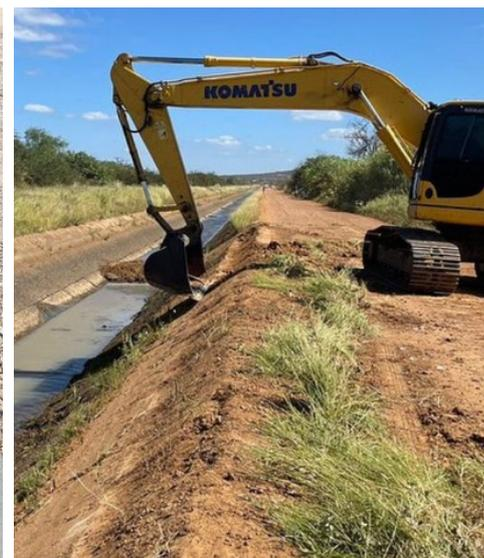
Desassoreamento de 12 km do Canal de Irrigação.
