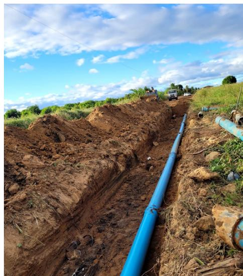
Substituição de mais de 7 mil metros de tubulação de amianto por PVC.
